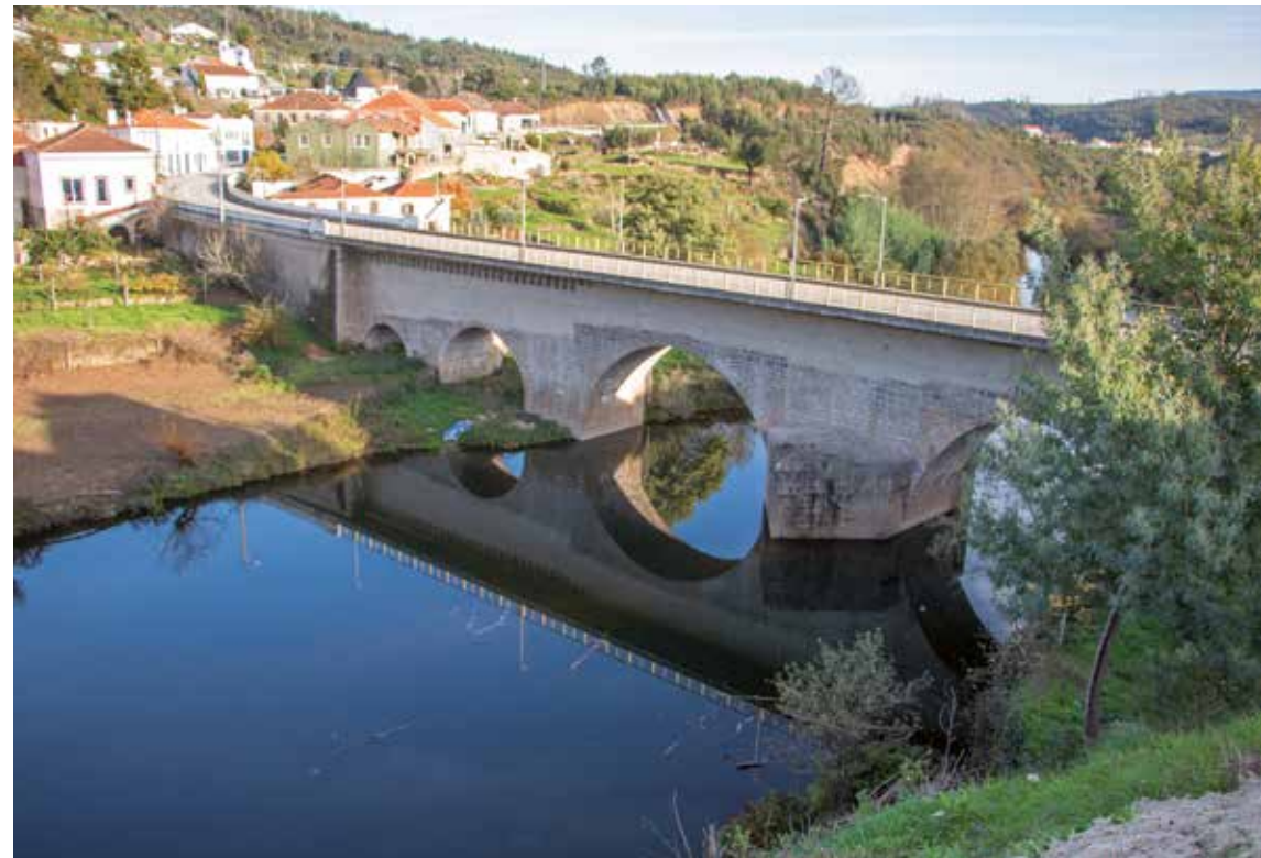
▲ Ponte da Mucela (Vila Nova de Poiares / Arganil) / Mucela Bridge (Vila Nova de Poiares / Arganil) ▲ © Município de Vila Nova de Poiares
