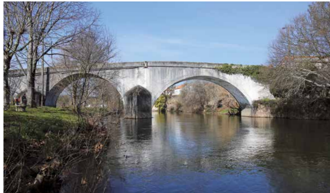
Ponte da Foz de Arouce (Lousã) / Foz de Arouce Bridge (Lousã) ▲ © Gonçalo Martins, Município da Lousã
